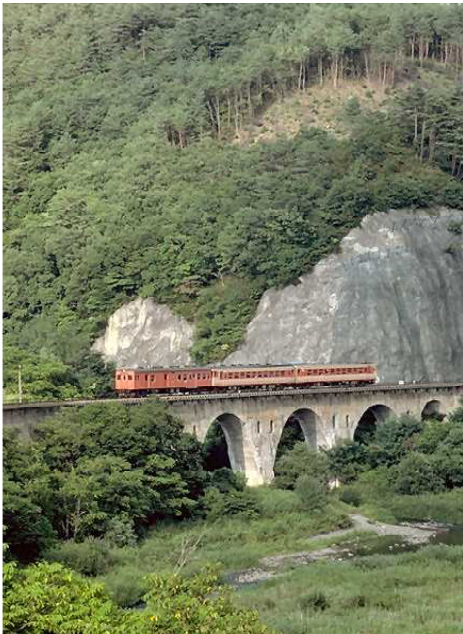
釜石線 岩根橋駅付近
